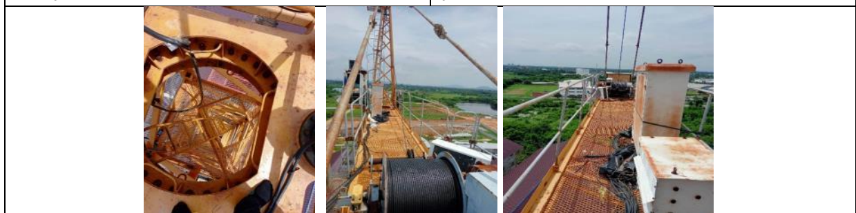
รูปที่ ผ7.42 บันไดพร้อมราวจับและโครงโลหะกันตก
